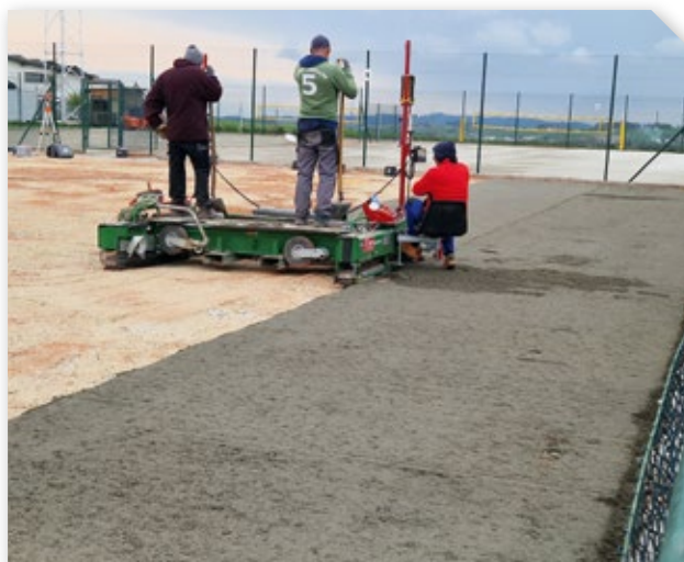
Auftragen der unteren Schicht für die neuen Tennisplätze.
