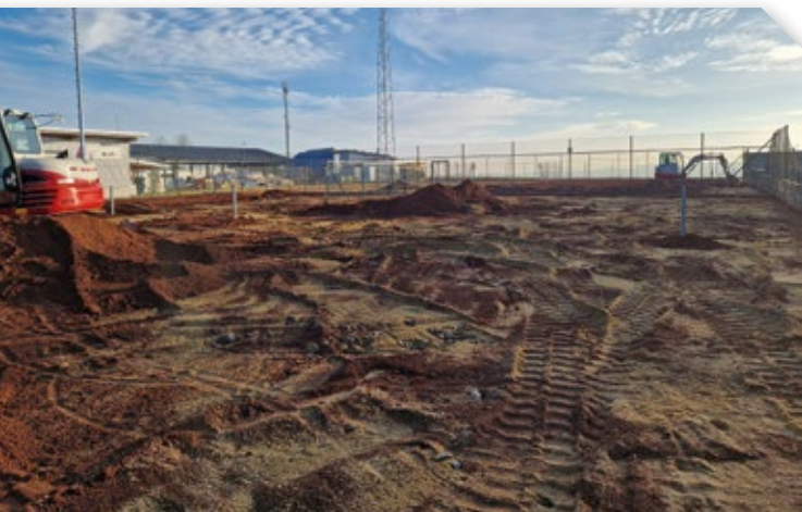
Abtragung des alten Sandbelages auf der Tennisanlage.
