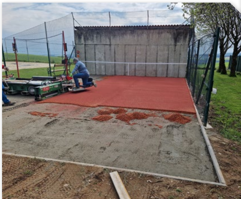
Auftragen des Spielbelages bei der Tenniswand.
